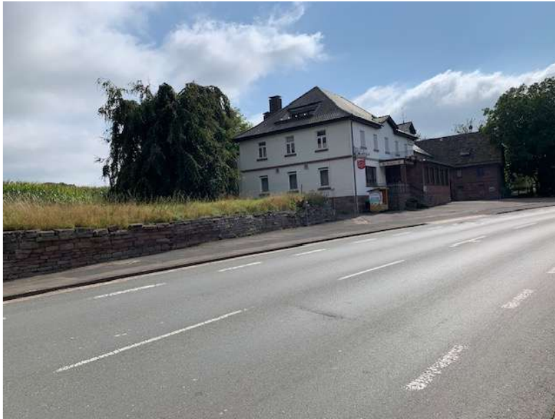
Blick von Nordwesten auf das Bestandsgebäude. Hinter dem Gebäude befinden sich Großbäume wie Linde, Tulpenbaum und Birke.
