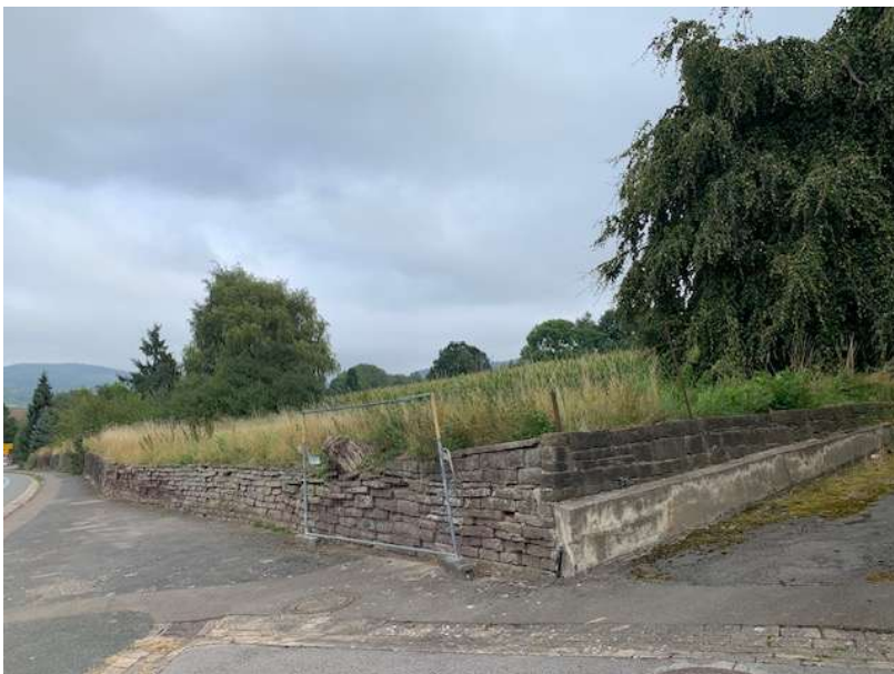
Blick von Südwesten auf das schmalere werdende Plangebiet. Zur angrenzenden Durchgangsstraße, der ehemaligen Bundesstraße 64, wird das Gelände mit einer Natursteinmauer abgefangen. Die Mauersteine sind im südlichen Teil nicht verfugt.
