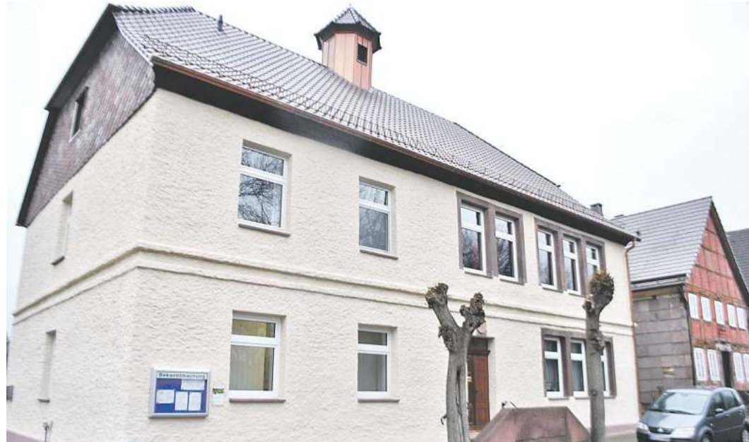
Die alte Schule wurde mit DE-Geldern von der Gemeinde gründlich saniert. Für die „neue“ Schule will die Samtgemeinde in 2019 Sanierungsmittel aus einem anderen Förderprogramm verwenden.
