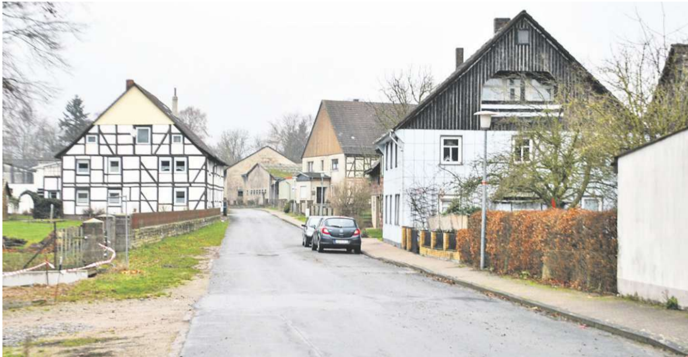
In diesem Teil der Straße „Winkel“ soll mit der Erneuerung begonnen werden.
