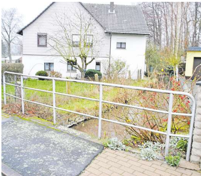
Eine von zwei Brücken im Verlauf des „Winkel“.
